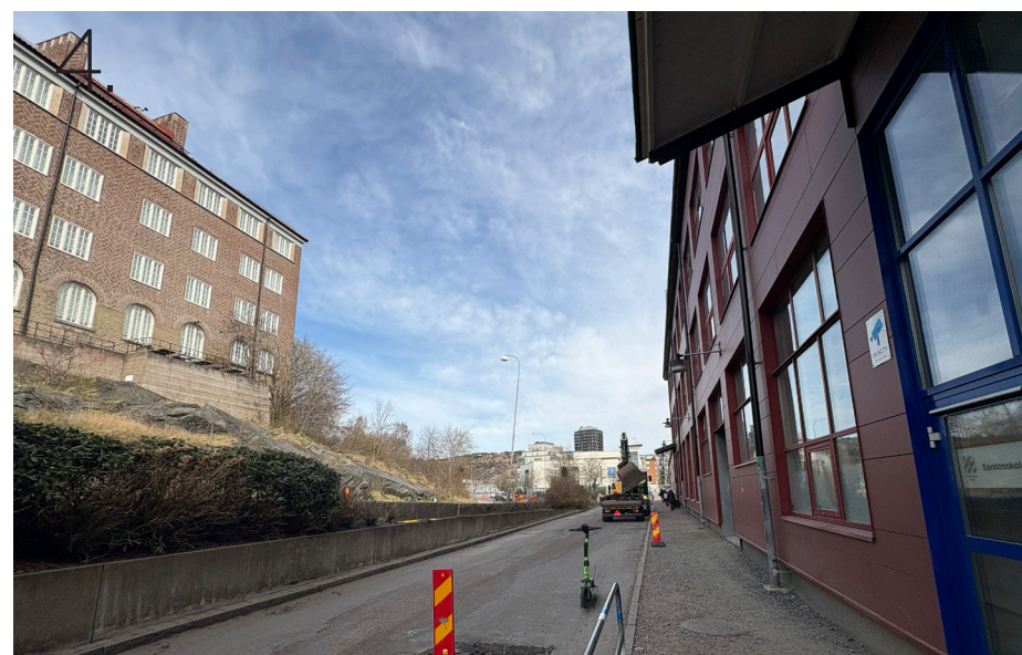
Vy från Plejadgatan norrut. Längs Plejadgatans båda sidor möts arbetar- och institutionsbyggnaderna på Skateberget och den tidigare arbetsplatsen med f.d. varvsbyggnader på den låglianta marken öster om berget. Den öppna vy som Plejadgatan erbjuder, visar på hur tätt varvet och bostadsbebyggelsen varit placerade och gör att områdets bebyggelse fortsatt kan upplevas i sitt historiska sammanhang.
