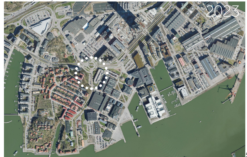
Ortofoto 2023. Lindholmsallén med plats för spårvagnstrafik och cirkulationsplatsen håller på att färdigställas. Den före detta parkeringsplatsen inom planområdet har rivits och ersatts med ett parkeringshus. Norr om planområdet har omvandlingen av kv Propellern påbörjats.
