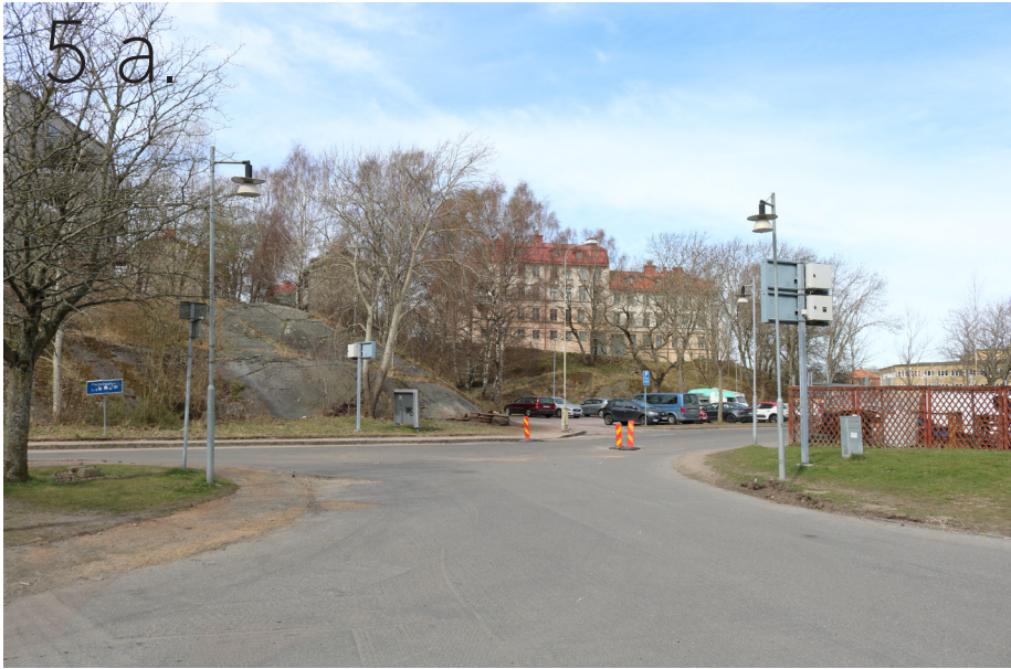
5 a. Visuellt samband, vy från varvsområdet upp mot bostadsbebyggelse samt skola på Skateberget. Det visuella sambandet förtydligar förståelsen för den historiskt nära kopplingen mellan arbetarbostäderna och arbetsplatsen i varvsområdet.
